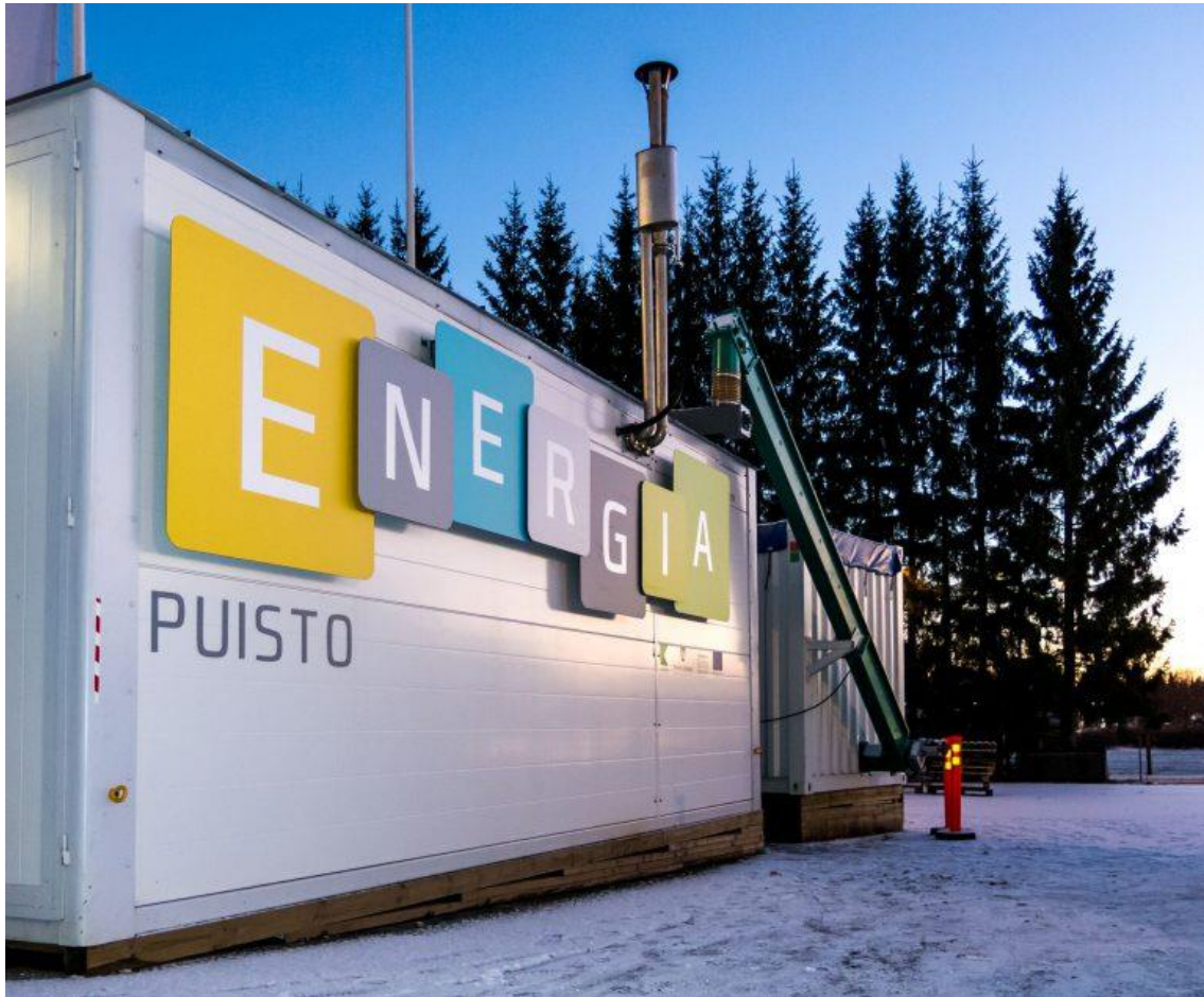
Kuva 9. Volter 40 laitos kuvattuna ulkopuolelta (Energiaraitti 2019)
