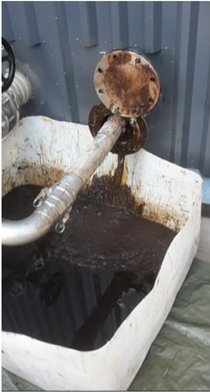
Kuva 6. Nestemäistä ja kiinteää RMÖ-sakkaa
