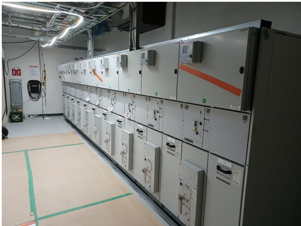
Kuva 5.1. Projektikohteen UniSec-kojeisto.
