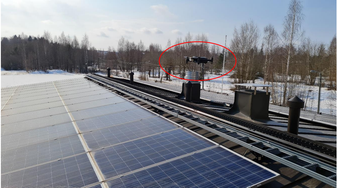
Kuva 20 Tytyrin vesilaitoksen katolla lämpökuvaus käynnissä
