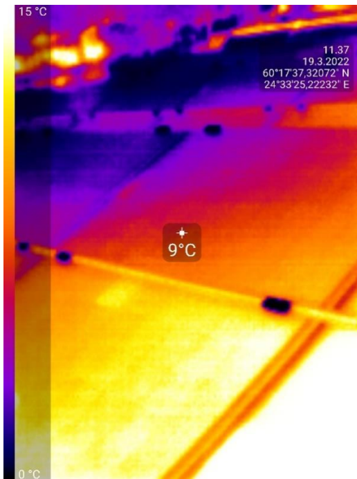
Kuva 18 Seek-lämpökameran kuva paneelista, jossa heijastumaa.
