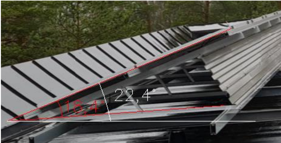
Kuva 14 Haltian aurinkopaneelien asennuskulma
