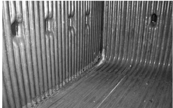
Kuva 13. Vas. Tulipesän eväputkiseinä (Smook, 2016), Oik. Tulipesän pohja (Andritz, 2022)
