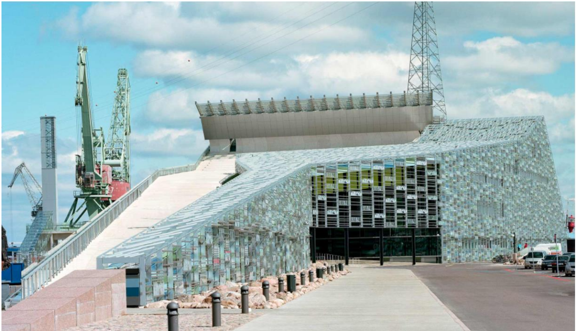
Kuva 7. Merikeskus Vellamon julkisivu ja kattorakenne (Merikeskus Vellamo, 2021).
