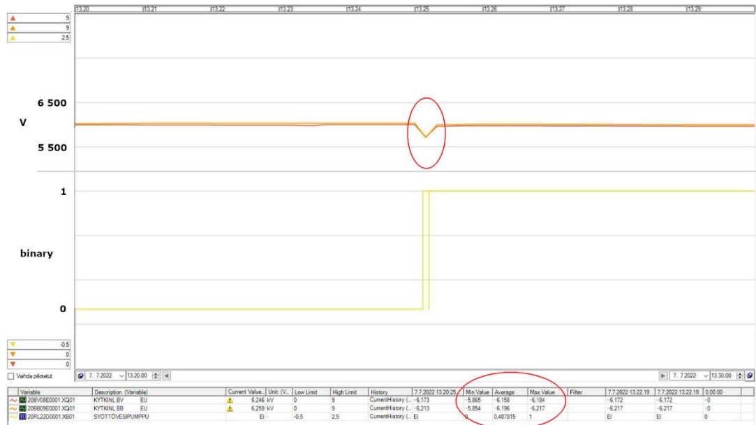
Kuva 17 Syöttövesipumppu 20RL22D001 kytkeminen (PTK – 2022-07-07 13:25)
