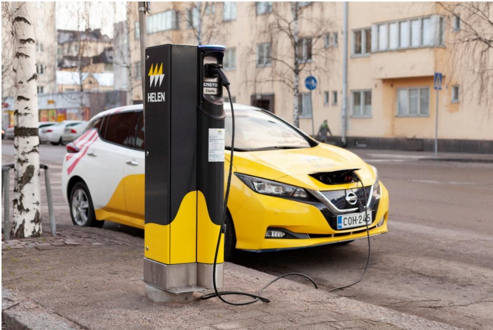
Kuva 4. Keskinopea latauslaite (Helen Oy arkistomateriaali 2020).
