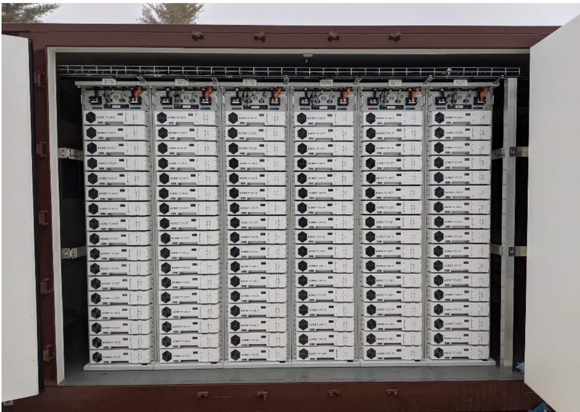
Kuva 19. Merikonttiin asennettu NMC-akusto (Kore Power 2022).
