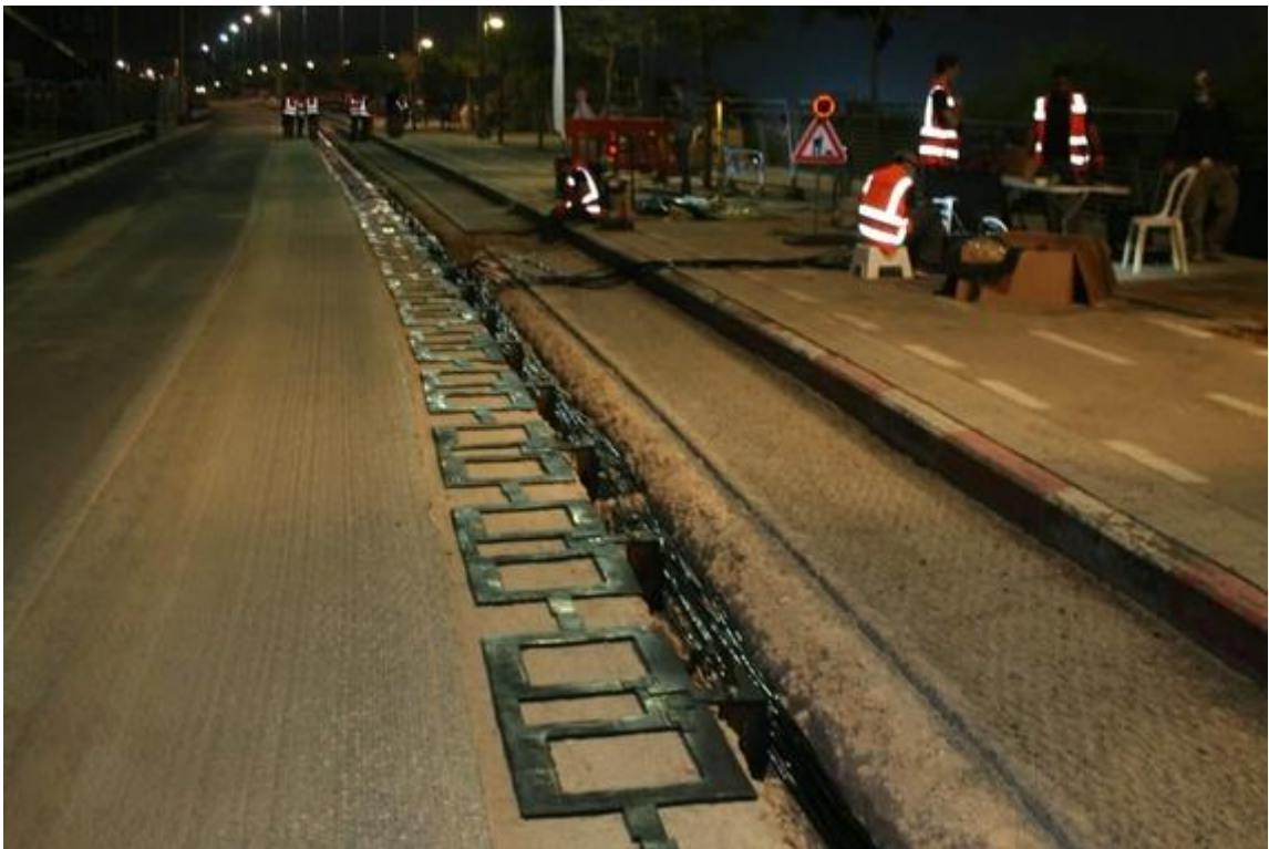
Kuva 10. Asfaltin alle tuleva langattoman latauksen järjestelmä. (Tekniikkatalous 2022)
