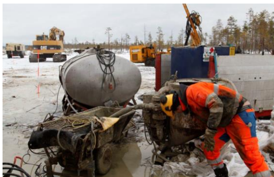
Kuva 6.4. Injektoinnissa käytettävän laastin valmistelu. (Risto Uusitalo, 2015).
