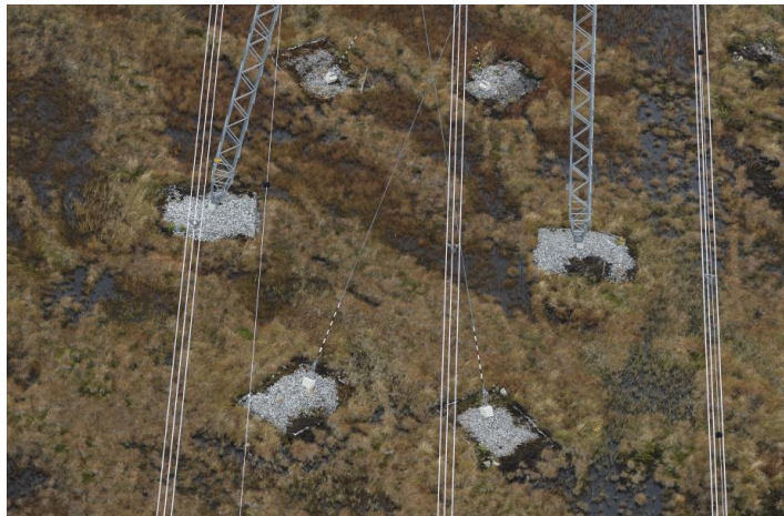
Kuva 6.14. Suoalueelle toteutettu harustetun pylvään elementtipierustus. (Fingrid, 2020).
