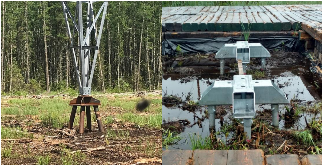
Kuva 3.11. Voimajohtojen ruuvipaaluperustuksia. (Magnum Piering, 2022).
