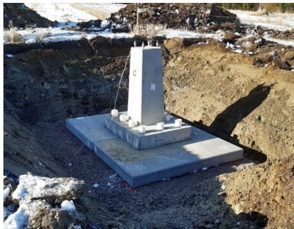
Kuva 3.2. 400 kV 1A-peltopylvään elementtiperustus. (Sami Liikanen, 2020).
