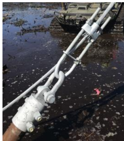
Kuva 3.12. Yksittäinen ruuvipaalu harusankkurina. (Magnum Piering, 2022).
