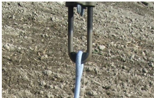
Kuva 7.4. Harukseen lisätty eristyspala. (Fingrid Oyj, 2006).
