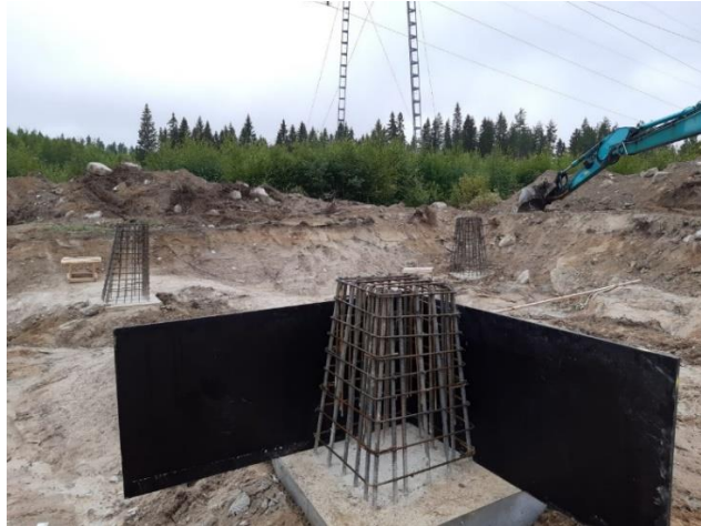
Kuva 3.4. 400 kV vapaasti seisovan 3Y-kiristyspylvään kallioperustus. (Sami Liikanen, 2020).
