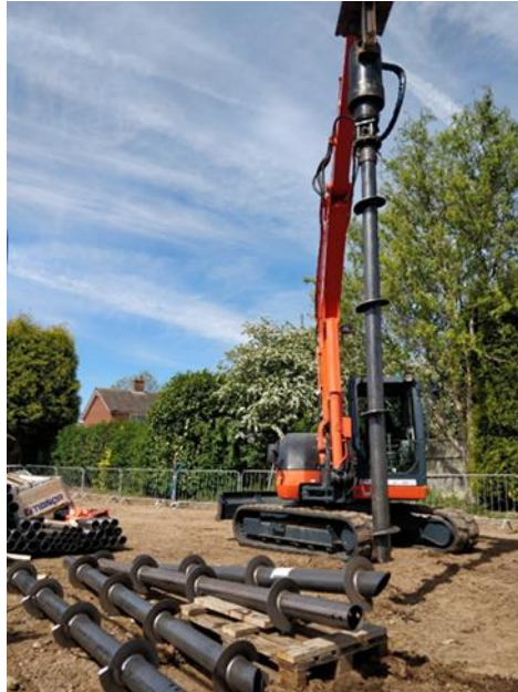
Kuva 6.5. Ruuvipaalun asennus kaivinkoneella. (Paalupiste, 2022).
