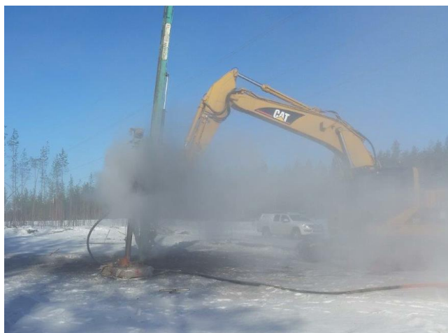
Kuva 6.1. Porapäristyksen asennus harustetulle pylväälle. (Risto Uusitalo, 2015).
