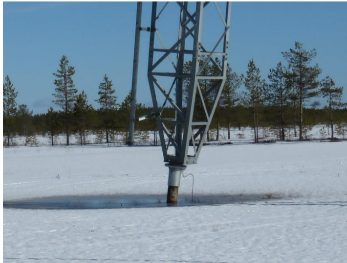
Kuva 3.6. 400 kV harustetun pylvään teräsputkipaaluperustus. (Risto Uusitalo, 2017).
