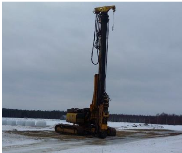
Kuva 6.2. Paalutuskone. (Risto Uusitalo, 2015).
