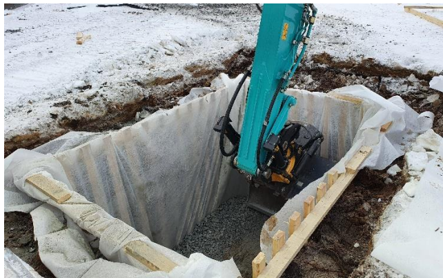
Kuva 3.5. Massanvaihto ja suojaseinät pilariharusankkurille. (Sami Liikanen, 2021).
