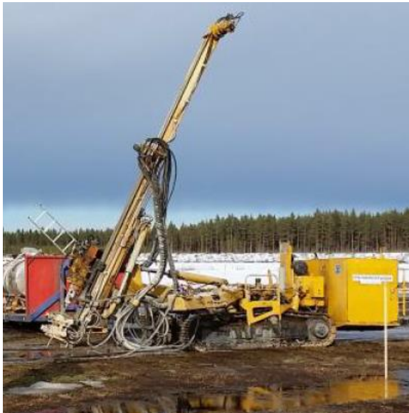
Kuva 6.3. Injektoitavan pora-ankkurin asennus poravaunulla. (Risto Uusitalo, 2015).
