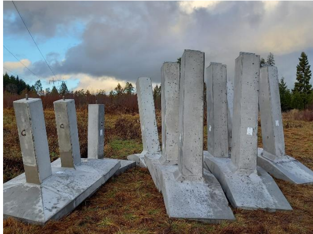
Kuva 3.1. Harustetun voimajohtopylvään perustuselementtejä. (Sami Liikanen, 2020).
