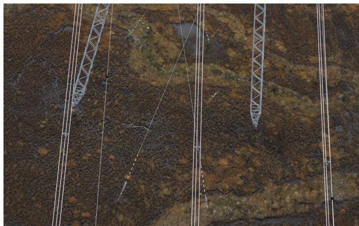
Kuva 6.15. Suoalueelle toteutettu harustetun pylvään teräspierustus. (Fingrid, 2020).
