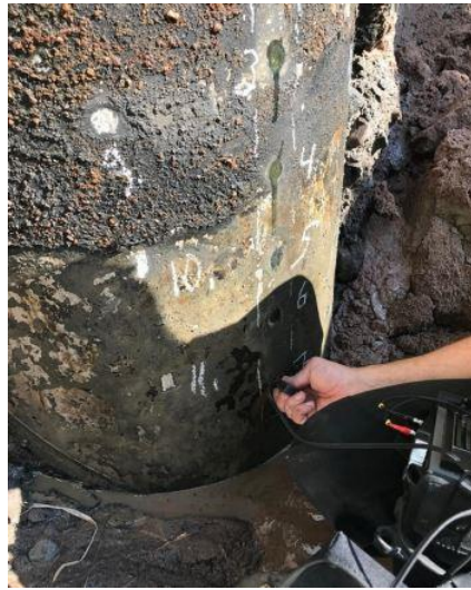
Kuva 7.9. Teräsputkipaalun seinämävahvuuden mittaaminen. (Väylävirasto, 2020).
