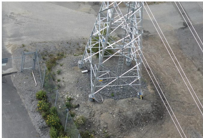
Kuva 6.16. Kaupunkiympäristöön toteutettu porapaaluperustus. (Fingrid, 2020).
