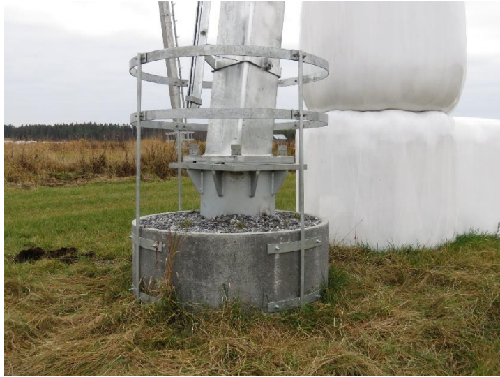
Kuva 3.7. 400 kV peltopylvään teräsputkipaaluperustus. (Risto Uusitalo, 2016).
