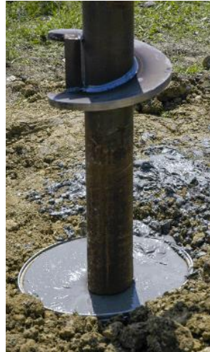
Kuva 7.8. Ruuvipaalun korroosiosuojaus laastipeitteellä. (Magnum Piering, 2022).
