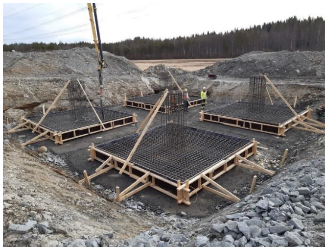
Kuva 3.3. 400 kV vapaasti seisovan 3Y-kiristyspylvään anturavalu. (Sami Liikanen, 2020).
