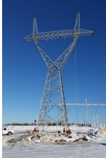
Kuva 2.5. 400 kV 4Y-kiristyspylväs ennen johtimien asennusta. (Sami Liikanen, 2017).
