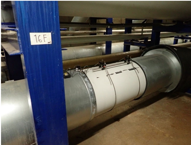
Kuva 25. Ultraäänisondien kiinnitys VF60-putkeen virtausmittausta varten
