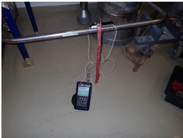
Kuva 23. TF13-putken sivuhaaran virtauksen mittaus ultraäänivirtausmittarilla
