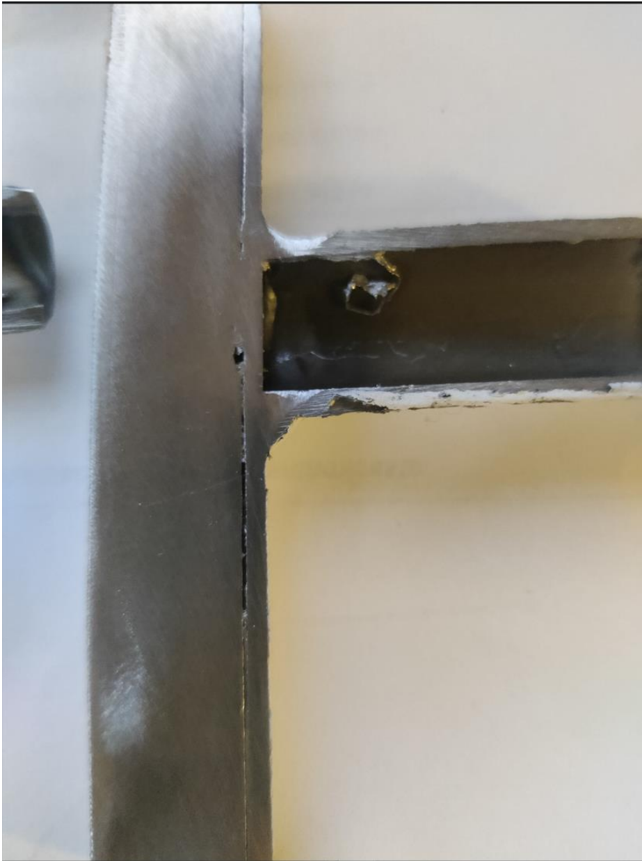
Kuva 24. Liitos ja hitsi auki leikattuina
