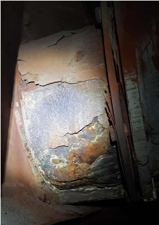
Kuva 5. Polttoaineen syöttöputken ulkopinnan korroosio (Jari Morko, Savon Voima Oyj)
