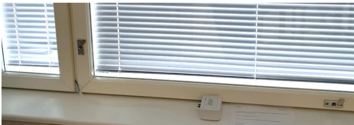
Kuva 5. Painelähettimen asennus ikkunalaudalle ja läpivienti tuuletusikkunan kautta
