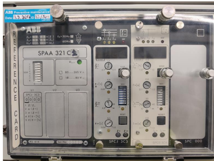
Kuva 4.2 ABB:n SPAA 321 C1 staattinen syötön suojapaketti, joka sisältää ylivirtarelemoduulin ja suunnatun maasulkurelemoduulin.
