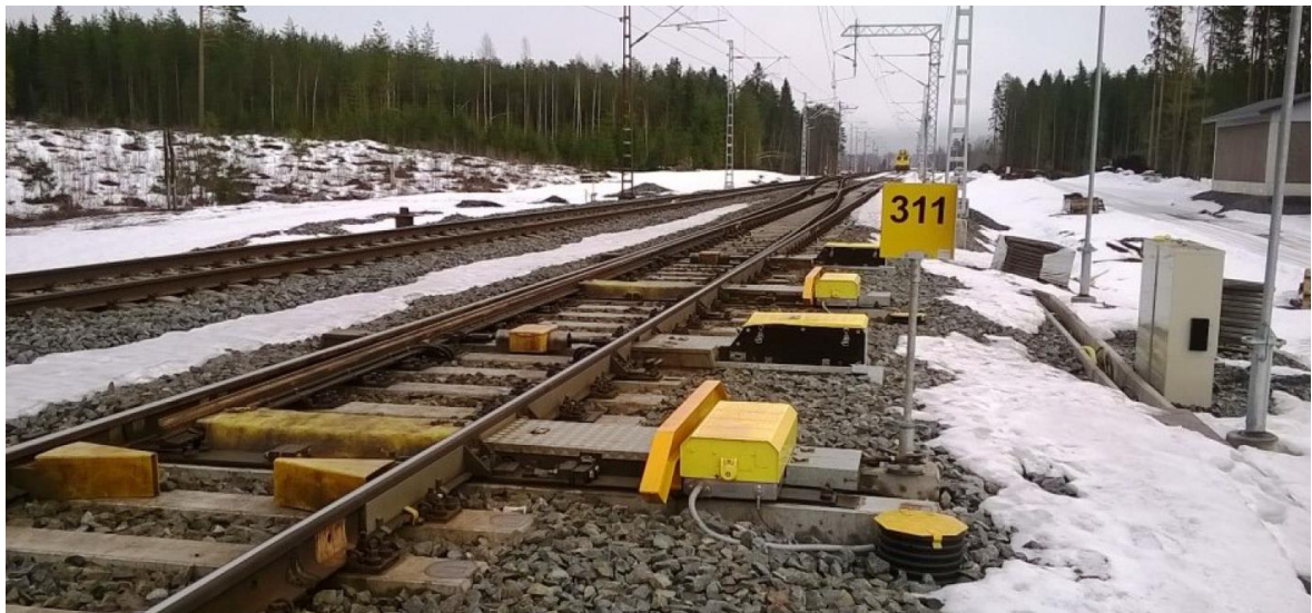
Kuva 8. Pitkä vaihde kahdella kääntölaitteella ja kääntöavustimella. (AEL 2017)
