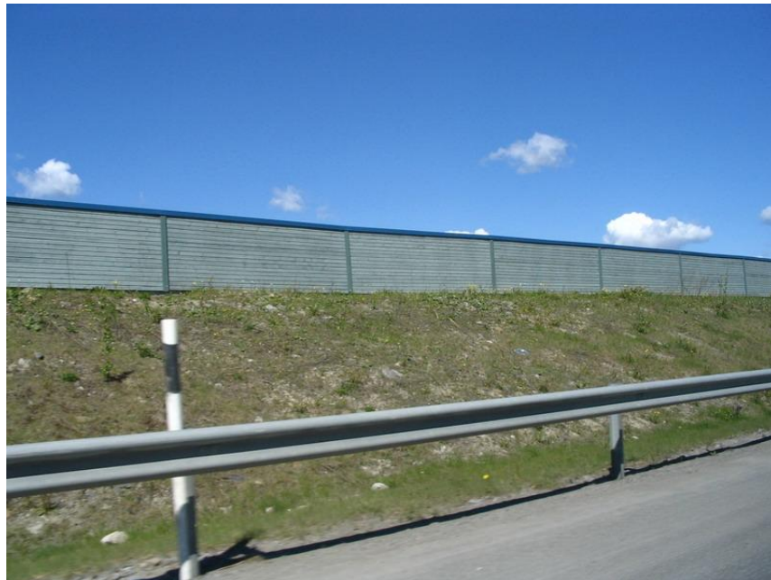
Kuva 1.1. Esimerkki ulkotilan meluntorjunnasta. Tienvarteen rakennettu meluvalli estää liikennemelun etenemistä tien ympäristöön. (kuva: Mikko Kuisma)
