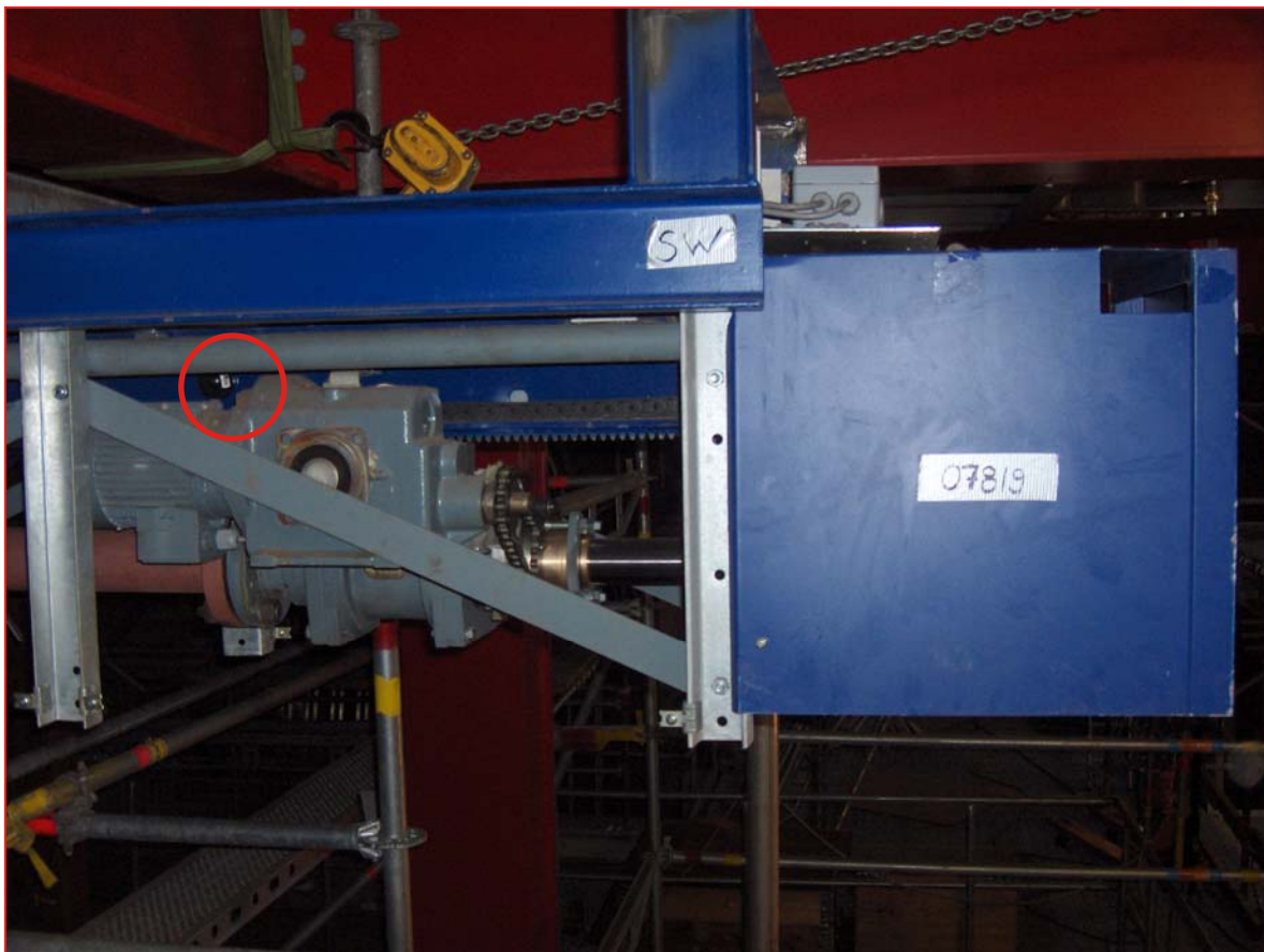
Kuva 4.2 Nuohoin, johon on kiinnitetty musta eTag. eTag on ympyröity punaisella.
