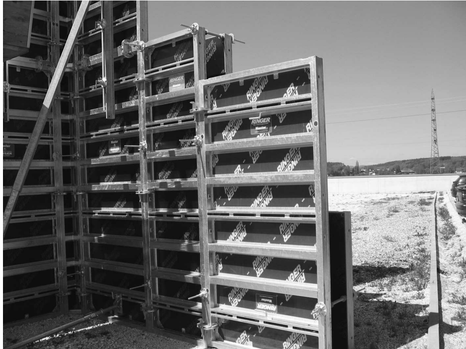
Kuva 9. Vanerisia betonivalumuotteja asennettuna valua varten. (UPM-Kymmene Wood Oy 2007)
