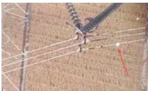
Kuva 1. Koronapurkaus keskivaihejohtimella.
