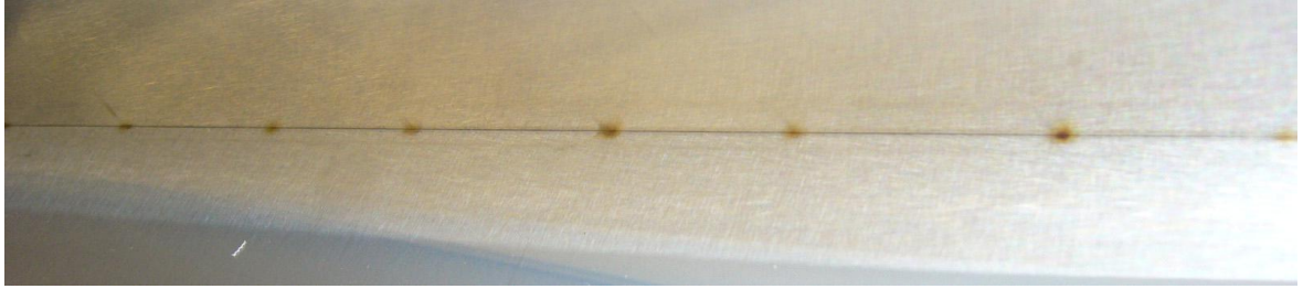
Kuva 23. MicroTackilla silloitettu kulmaliitos.
