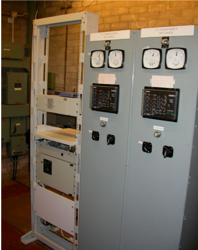
Kuva 4.5. GenAVC™ asennettuna ohjaamaan kahta jännitteensäätörelettä. (Econnect 2005)
