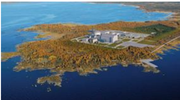
Kuva 3. Pyhäjoen Hanhikivi, EPR. (Fennovoima, Laitospaikan valinta)
