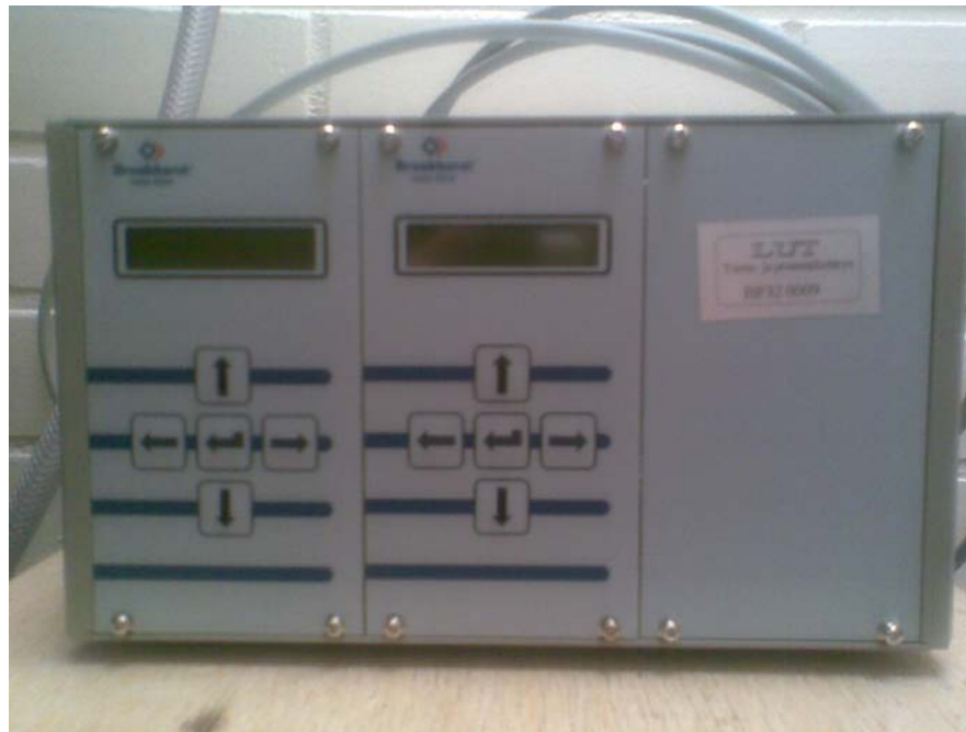
Kuva 8. Virtauksen säätölaitteisto, jolla ohjataan typen ja hapen virtausta reaktoriin.
