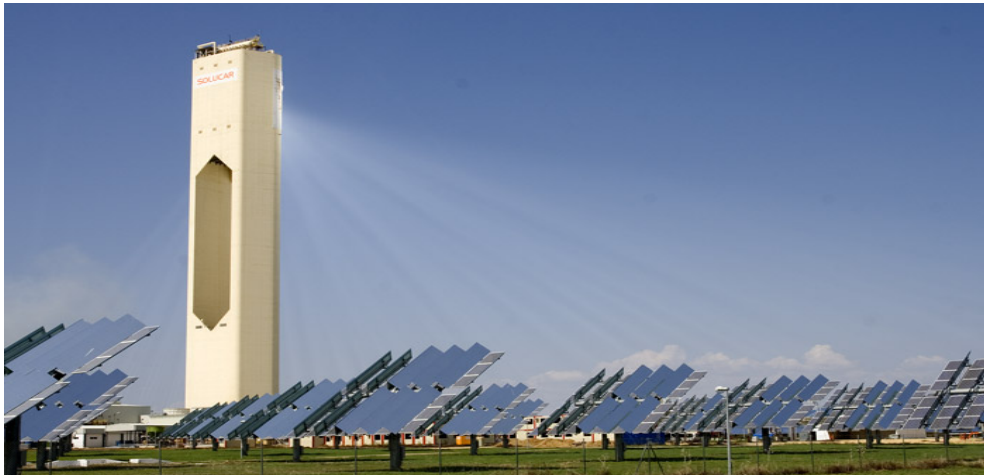
Kuva 8. Aurinkotorni Sevilla, Espanja. (cnfolio.com)
