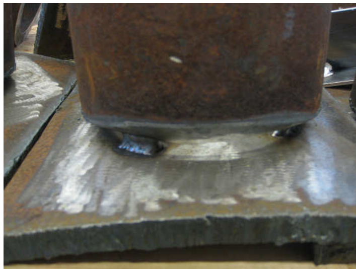
Kuva 19. Käsivaraisesti polttolaikattu railo, johon siltahitsillä kiinnitetty putki. Robotisointia tällaiseen ei kannata lähteä yrittämään, koska hitsiä ei saa onnistumaan laadullisesti.
