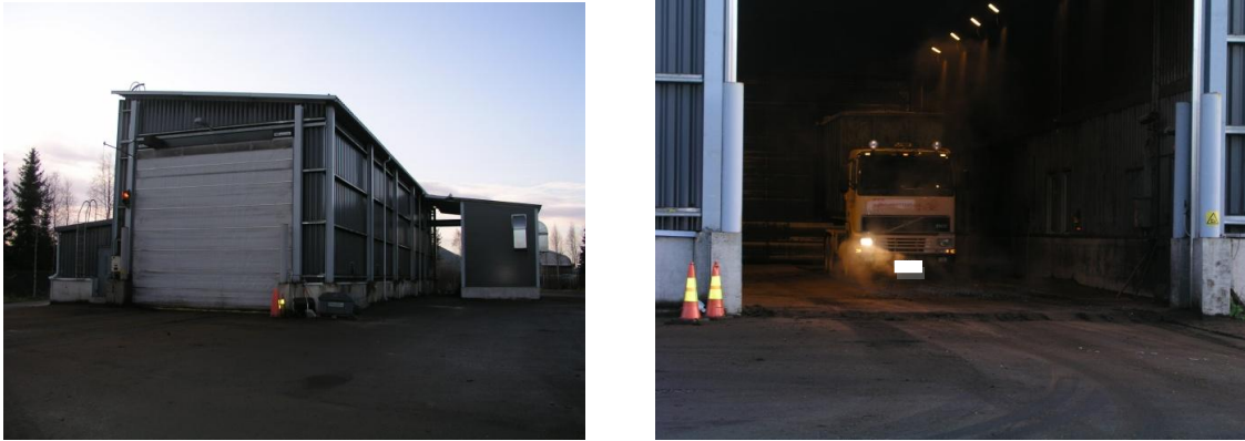
Kuva 3 ja 4. Turpeen ja puupolttoaineiden vastaanottoasema.
