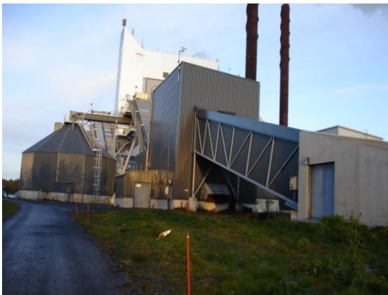
Kuva 6. Turpeen ja puupolttoaineiden käsittelylaitteet.
