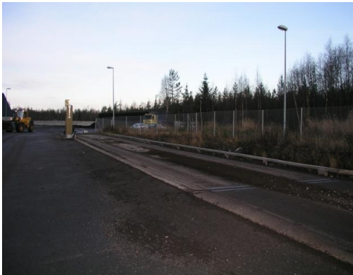
Kuva 12. Suosiolan voimalaitoksen vaaka.
