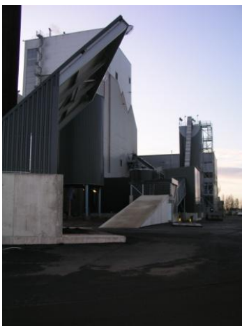
Kuva 11. Kivihiilen käsittelylaitteet.
