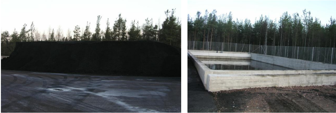
Kuvat 9 ja 10. Hiilikenttä ja selkeytysallas
