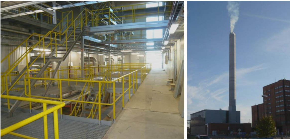
Kuva 5. Vasemmassa kuvassa lämpökeskus kuvattuna sisältä ensimmäiseltä tasanteelta ja oikeassa kuvassa lämpökeskus ulkoa.
