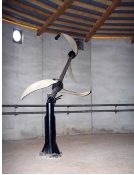
Kuva 6. Mädätys säiliö, jonka sisällä on pitkä-akselinen sekoittaja. (Christensson et al. 2009, 30.)
