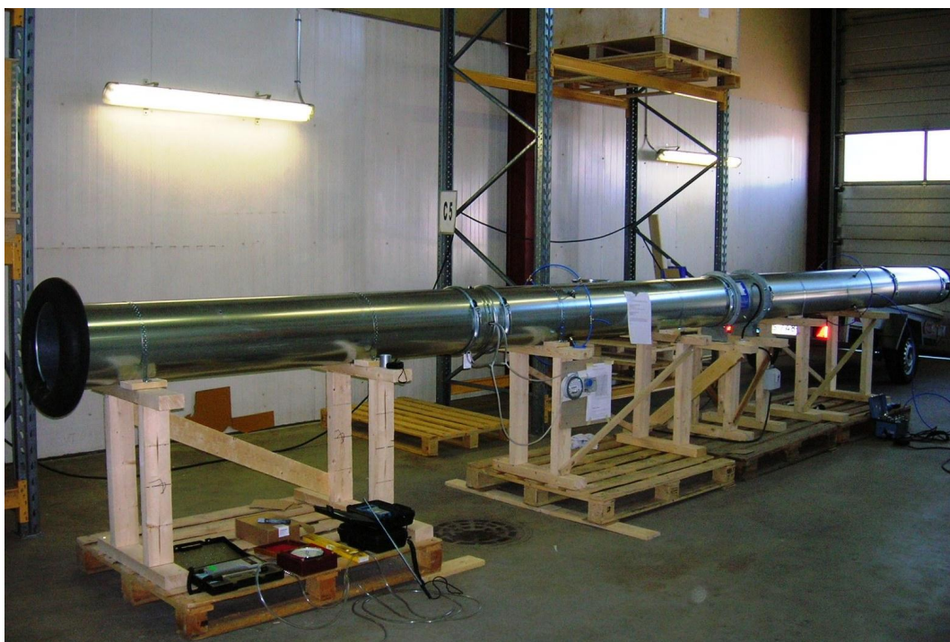
Kuva 3.1: Mittausjärjestely aksiaalipuhaltimen suoritusarvojen mittaamiseksi.
