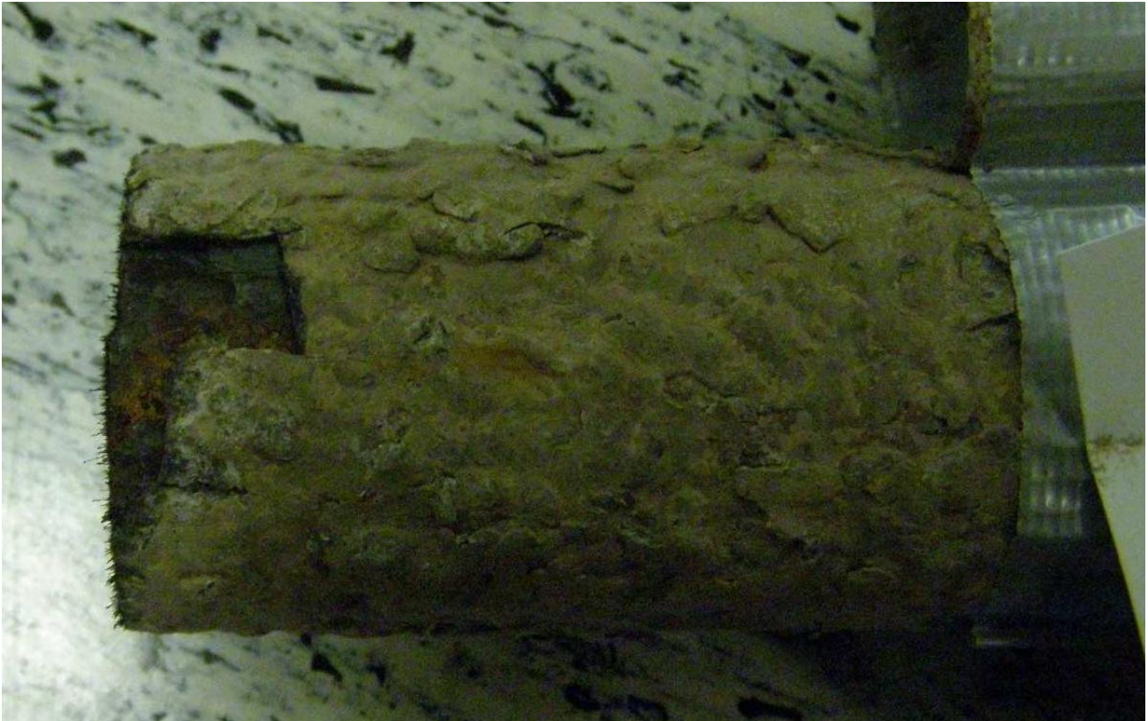
Kuva 10. IV – tulistimen näyteputken kerrostumaa. (Inspecta Oy. Soininen, R. 2009)
