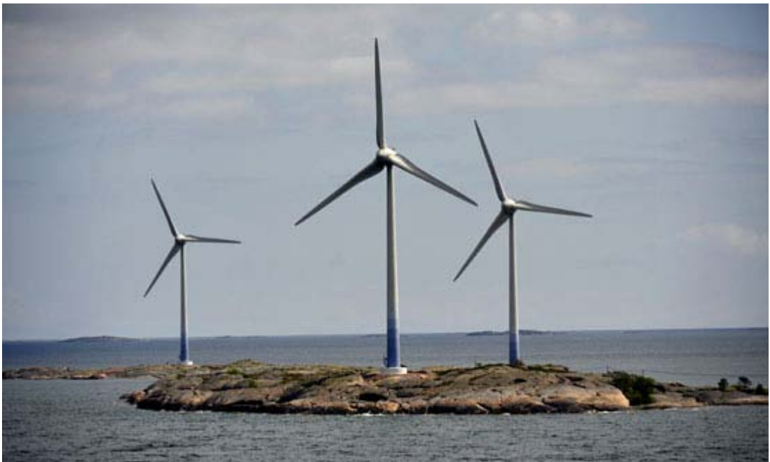
Kuva 3. Vaaka-akselinen tuuliturbiini. (Lehtikuva)
