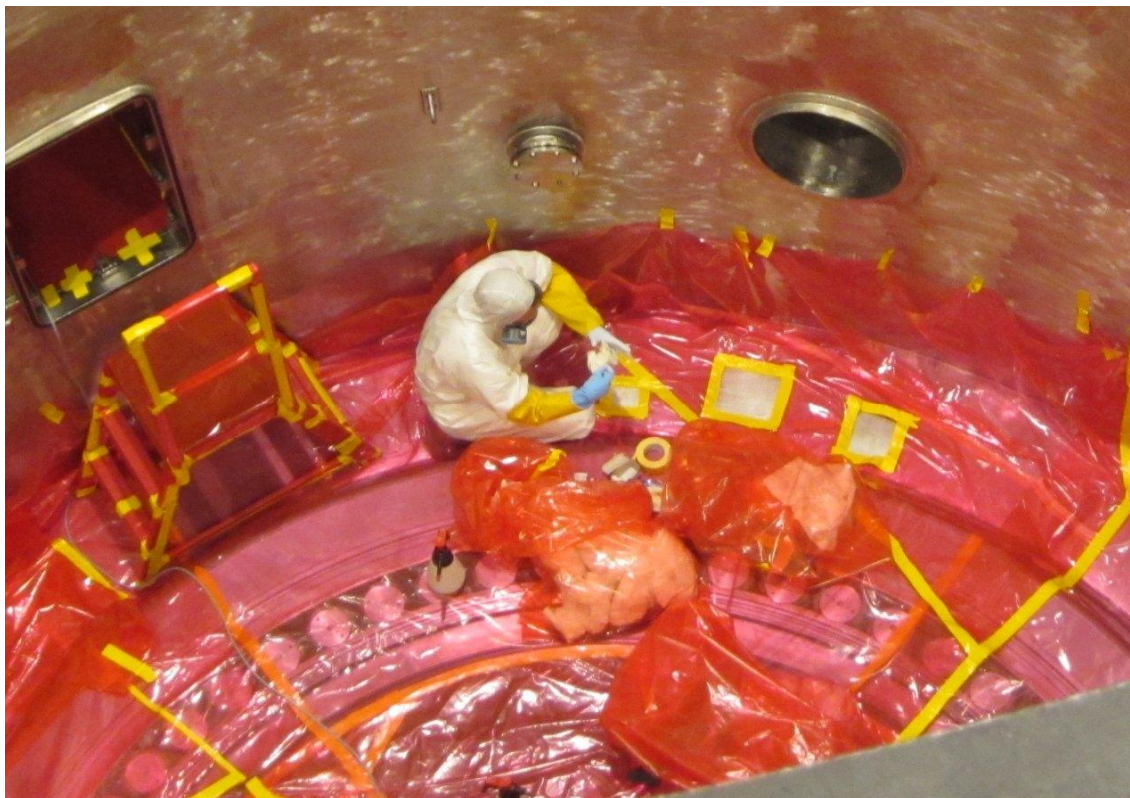
Liite 1. Kuva näytteenotosta reaktorikuilun pohjalta.
