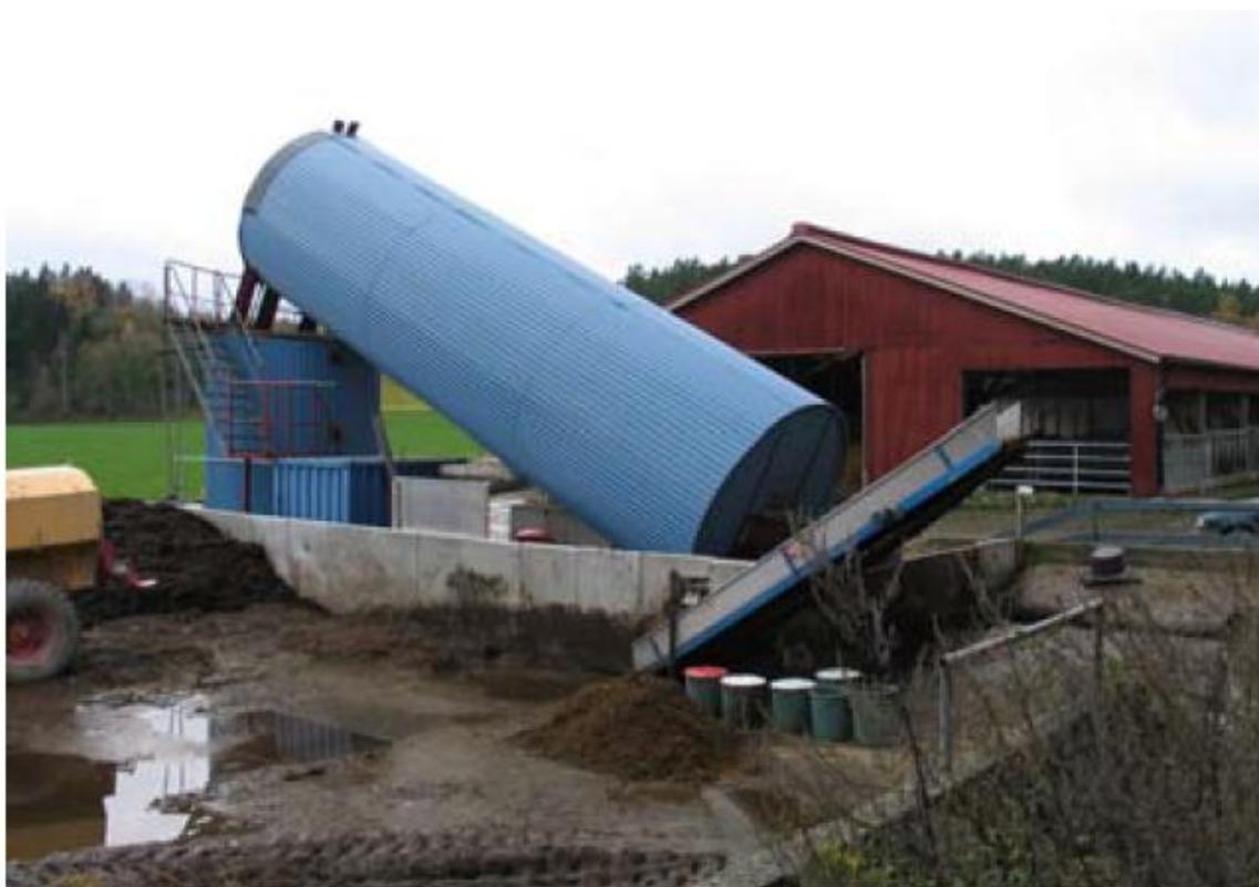
Kuva 15. Ruotsissa Ytterenebyn tilalla toimiva biokaasulaitoksen prototyyppi, joka tuottaa karjanlannasta, oljesta ja kaura-akanasta lämpöä (Schäfer & Lehto 2005).
