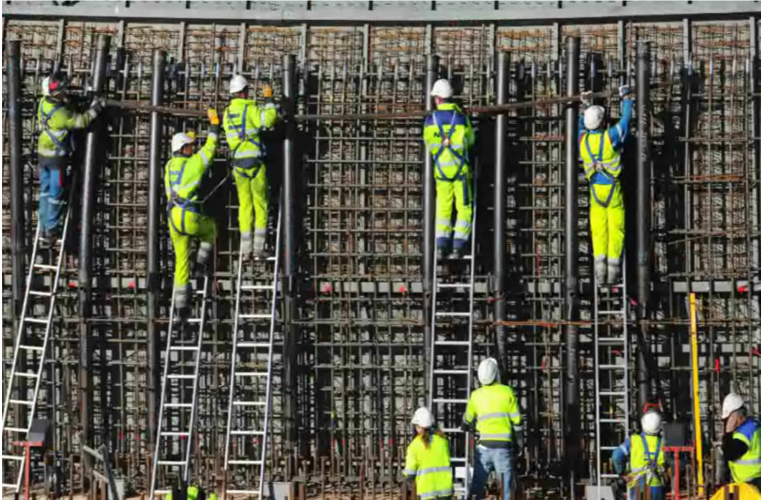
Kuva 12. Suojarakennuksen betoniraudoitustyötä OL3: reaktorin suojarakennukseen (TVO c)
