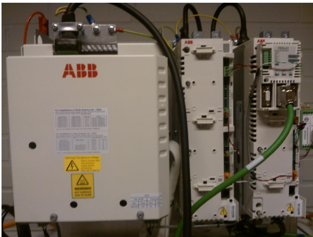
Kuva 11 Vasemmalta oikealle: WFU-suodinyksikkö, ACSM1-204 verkkovaihtosuuntaaja ja ACSM1-04 taajuusmuuttaja.
