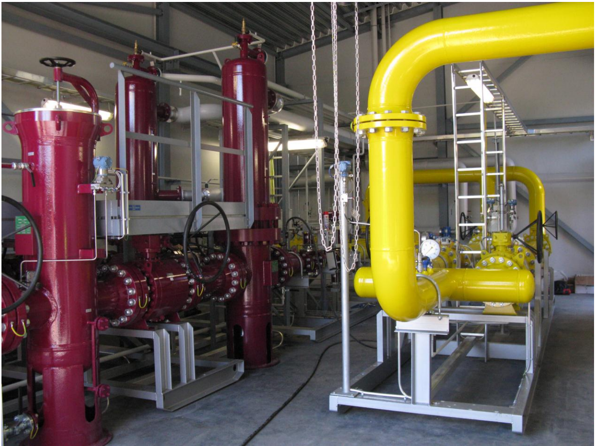
Kuva 2. Paineenvähennysaseman sisätilat
