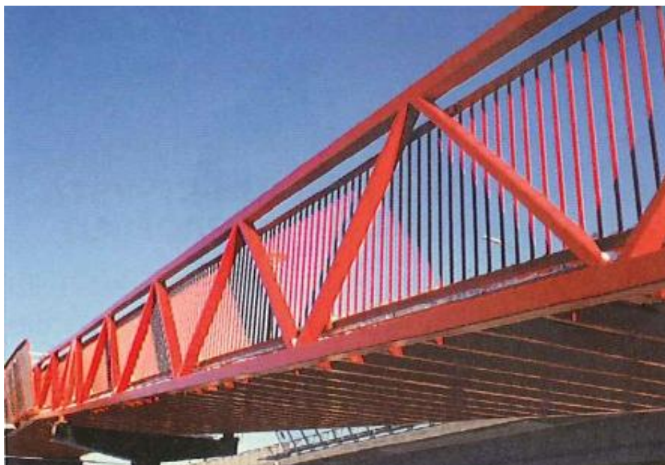
Kuva 10. Hitsaamalla valmistettu ristikkopalkki siltarakenteessa. /12/
