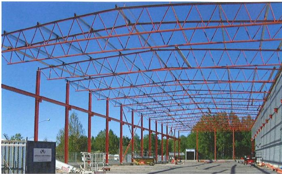
Kuva 9. Teräksinen ristikkorakenne hallirakennuksen kattorakenteessa. /12/
