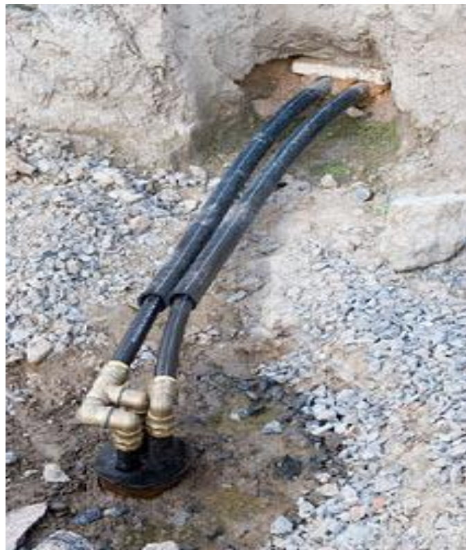
Kuva 6. Lämmönkeruupiiri toteutettuna 3 - putkijärjestelmänä. (Rakentaja. 2012a)
