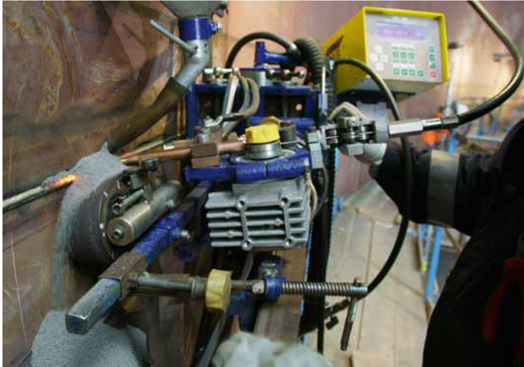
Kuva 20. Jauhekaarihitsausta PC-asennossa. Kuvassa näkyvä hihna estää hitsausjauheen valumisen sulasta (Altemühl, 1/2010.)
