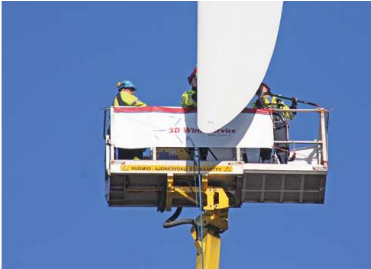
Kuva 12: Kuvassa miehet puhdistamassa tuulivoimalan lapaa nostokorista käsin
