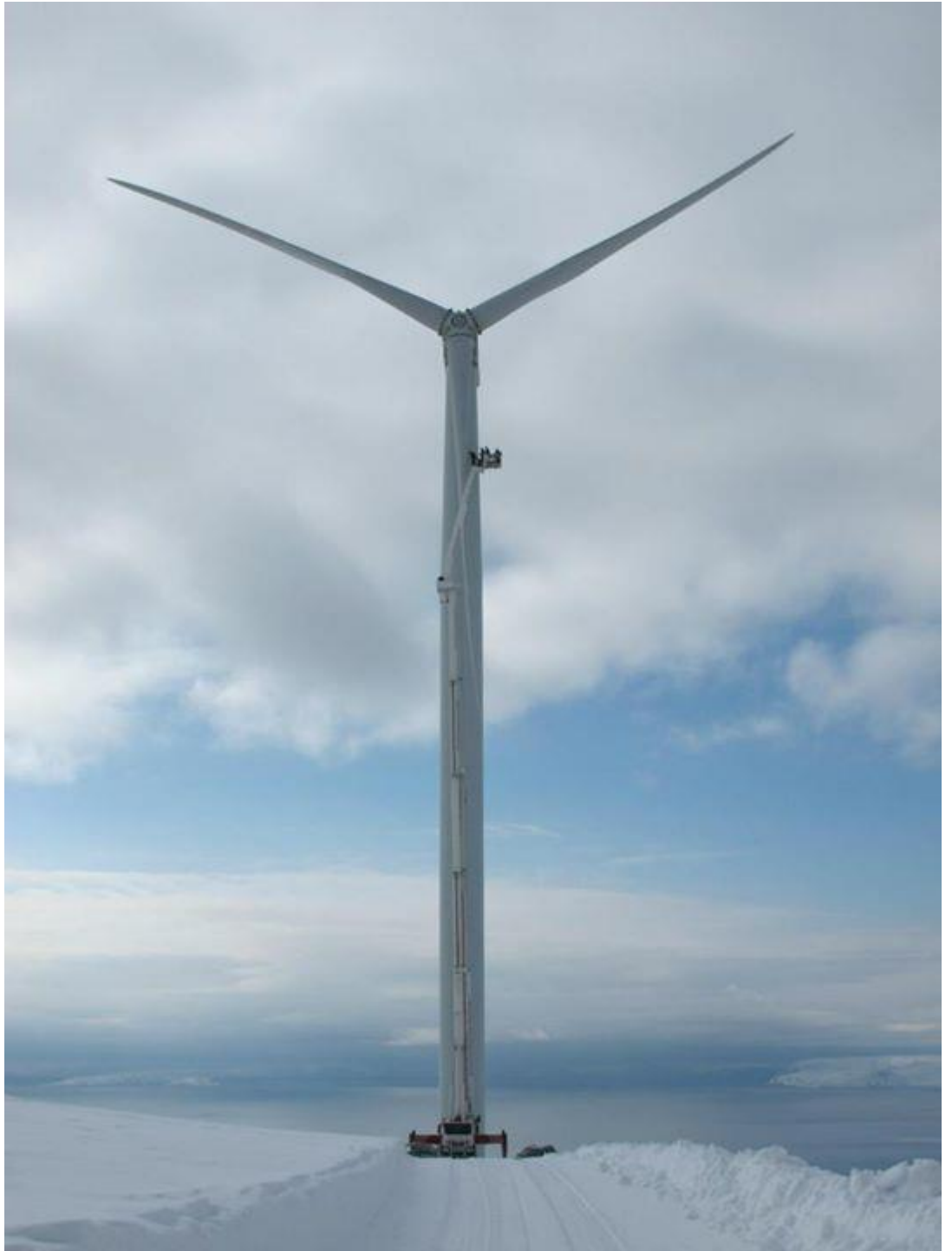
Kuva 13: Kuvassa nostokoriauto seisoo tuettuna omilla jaloilla tuulivoimalan edessä (Kuva Bladefence)
