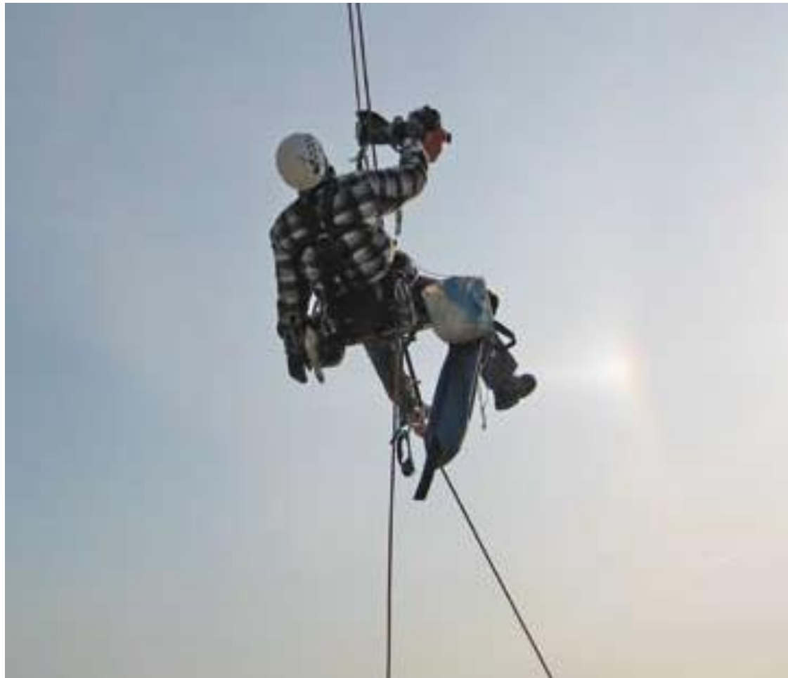
Kuva 10: Kuvassa huoltomies nousemassa köysimopolla (kuva Airice, Feodor Gurvits)
