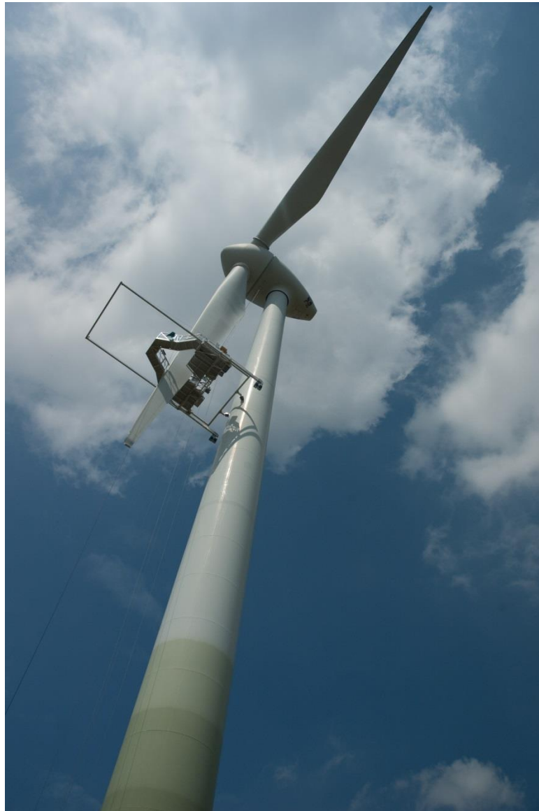
Kuva 11: Kuvassa huoltotaso (Gurvits F. Airice)
