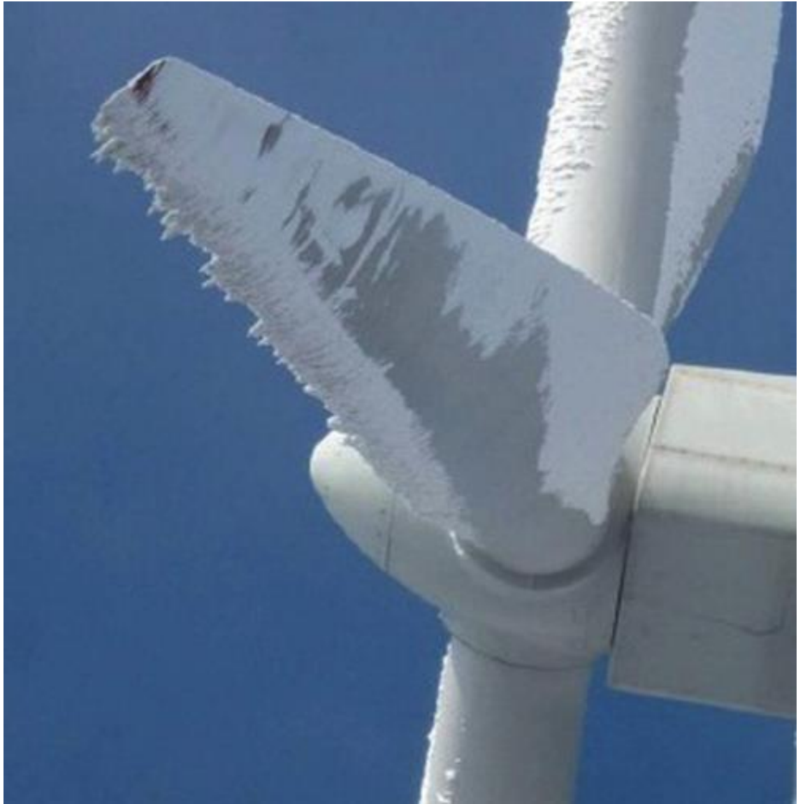
Kuva 9: Kuvassa jäätymistä tuuligeneraattorin lavoissa
