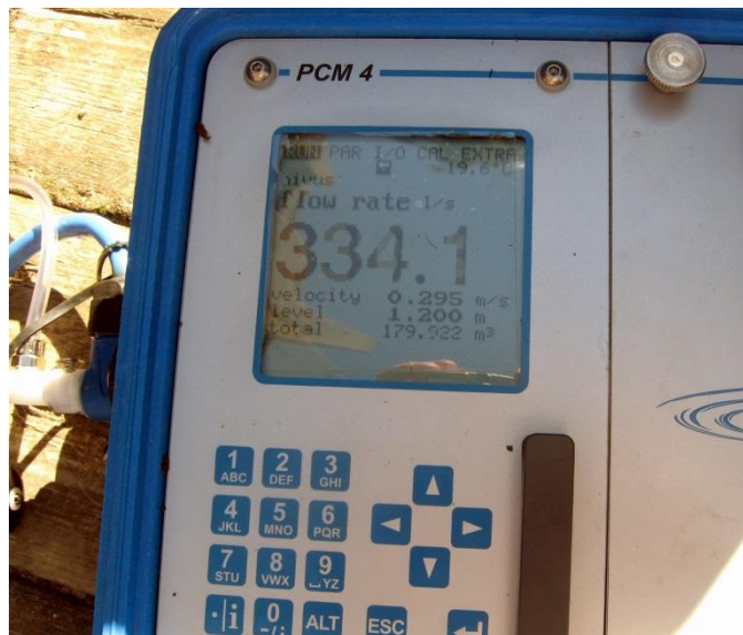
Kuva 5.1: Mittauslaitteiden asennus. (a) Takymetri mittausvalmiina. (b) Anturin asennus väljän välistä. (c) Nivus PCM 4 mittalaite mittaamassa.
