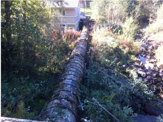
Kuva 4.4: Voimalaitoksen vesitiet. (a) Tuloputki. (b) Imuputki.
