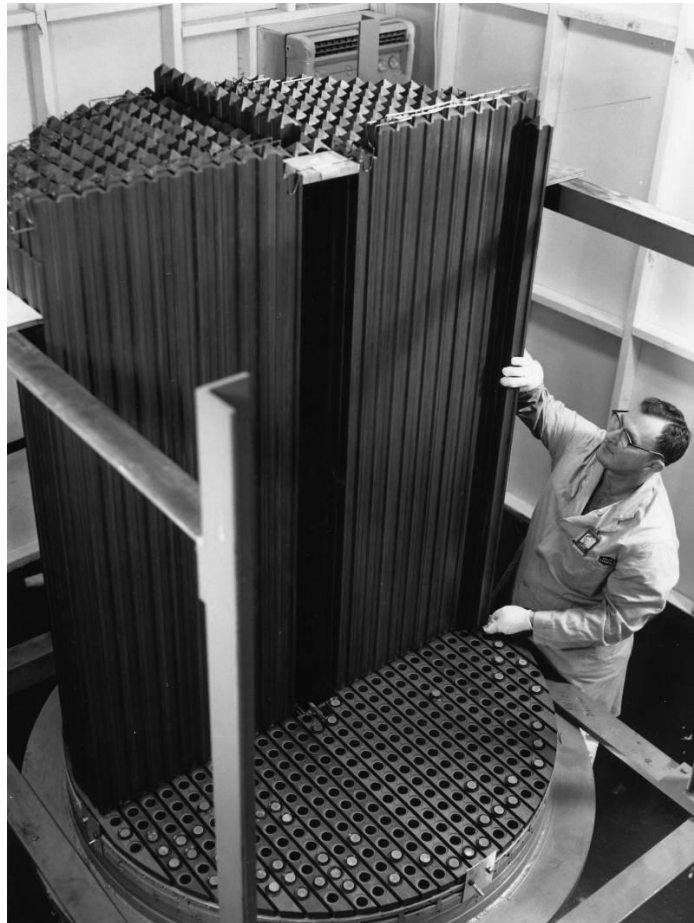
Kuva 5. MSRE:n grafiittisydän. Sydän koostui grafiittipalkeista ja kuvasta on nähtävissä myös palkkien pintaan työstetyt sulasuolakanavat. (Rosenthal 2009, 31)
