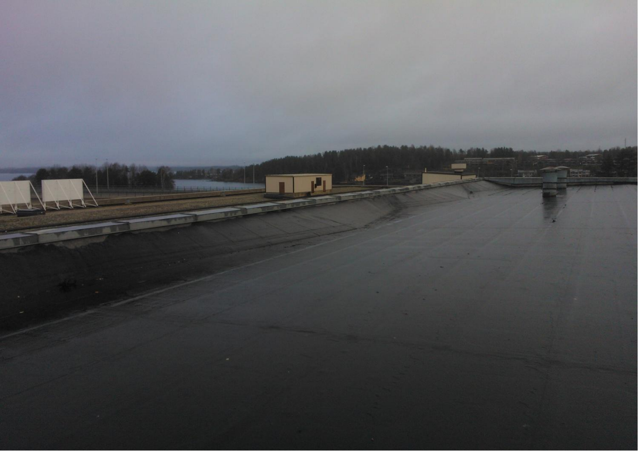
Kuva 3.1.1 Yrityksen ylempi kattotaso
