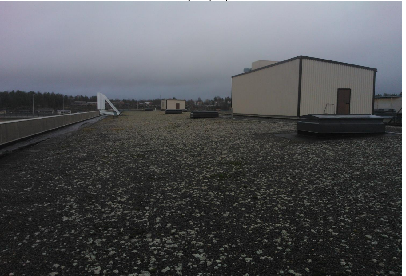
Kuva 3.1.2 Yrityksen alempi kattotaso
