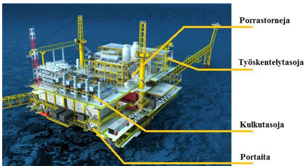
Kuva 24. Ritiläsovelluksia öljynporauslautalla (PSR, 2014).
