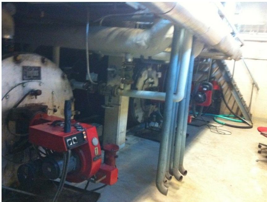
Kuva 4 Tervalammen nykyiset lämmityskattilat. Etualalla on kattila no 1 ja kauimpana on kattila no. 3, sähkökattila, joka sijaitsee kattilan 1 ja 2 välissä ei näy tässä kuvassa.
