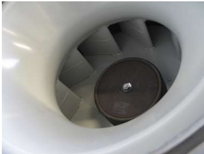
Kuva 11. Lähikuva kuvusta siipipyörän keskellä.
