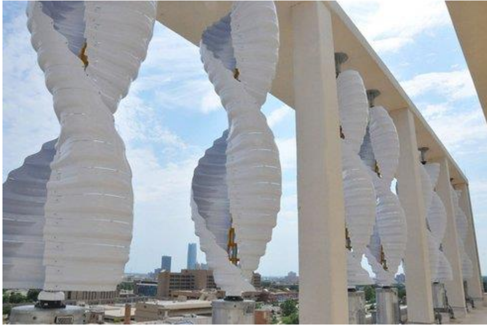
Kuva 2.5 Venger Wind V2 Savonius –tyyppiset tuulivoimalat asennettuna osaksi rakennusta.
