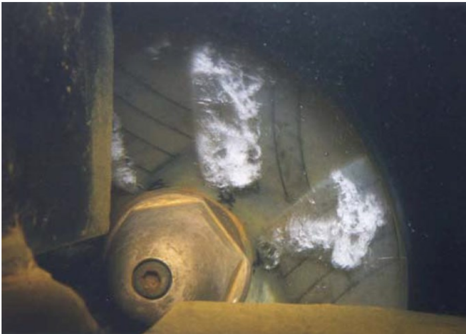
Kuva 13. Kavitaatiokuplia pumpun imupuolella juoksupyörän siiven etureunan tuntumassa, jossa virtausnopeus on suuri. (Sulzer Pumps 2010)
